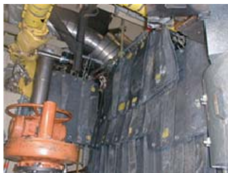
Protection de type « bracelet » sur un tuyau
