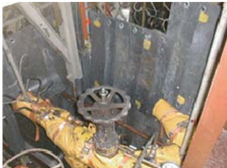
Installation d'une protection biologique sur un tuyau permettant la surveillance d'une vanne
