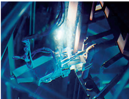
使用接觸式弧形金屬切割拆除反應爐壓力容器內部結構
