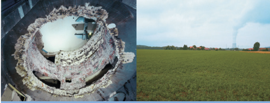
拆除生物屏蔽
