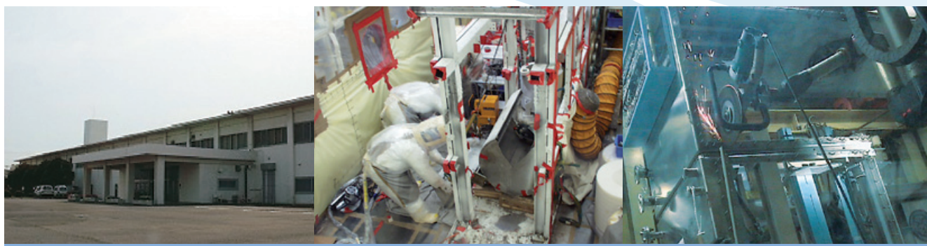
鈾燃料加工製造設施
