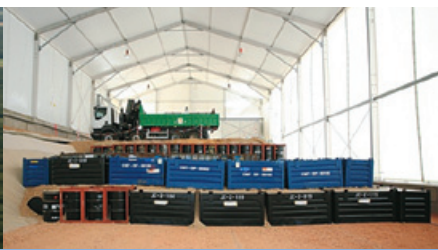
El Cabril 極低階放射性廢物處置場 (西班牙, 感謝ENRESA 提供照片).
