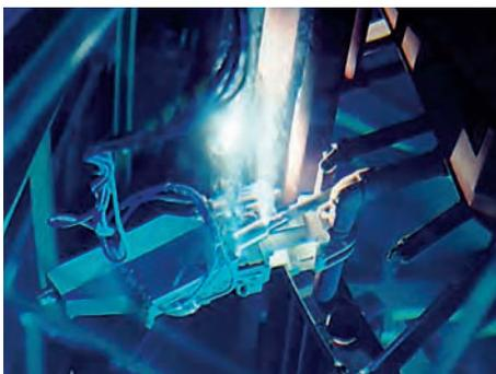
Démantèlement des internes de la cuve du réacteur par la technique de découpe par arc électrique au contact.
