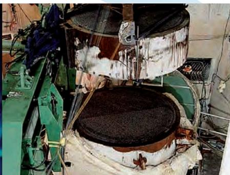
Démantèlement d'un générateur de vapeur préalablement congelé par la technique de sciage.
