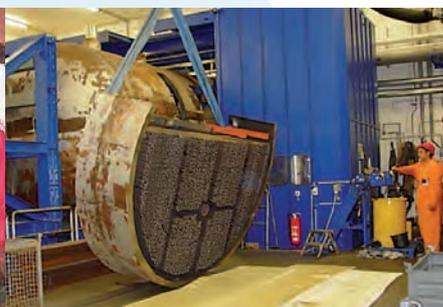
Découpe d'un générateur de vapeur à l'aide d'une scie à ruban de grande taille dans l'installation d'entreposage nord (ZLN).
