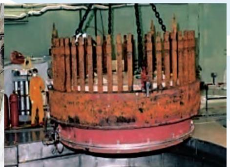
Démantèlement de la cuve du réacteur, transfert de la bride.
