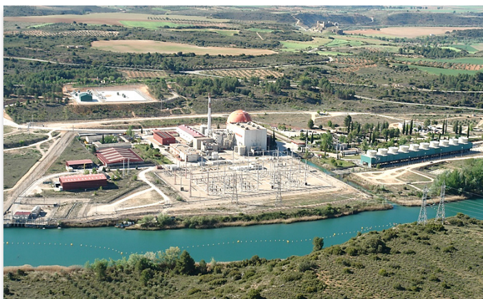
José Cabrera NPP site
