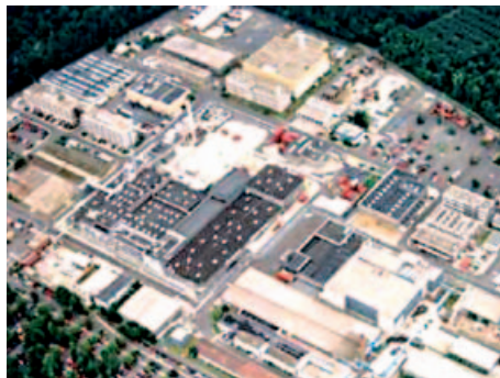
Anläggningen före avveckling.
