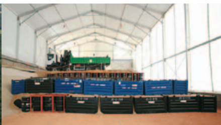
Deponering av mycket lågaktivt radioaktivt avfall (El Cabril, Spanien, foto: ENRESA).
