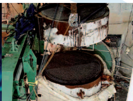
Sönderdelning av en ånggenerator med hjälp av "issågningsteknik".
