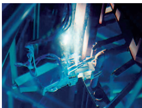
Sönderdelning av de interna delarna av en reaktortank med hjälp av skärbrännare.
