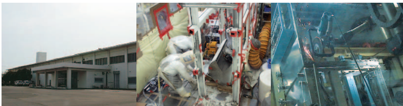
Anläggningen för tillverkning av plutoniumbränsle. Under nedmonteringen av handskboxar.
