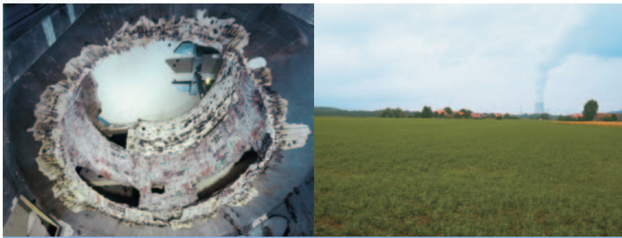
Nedmontering av den biologiska skärmen.
