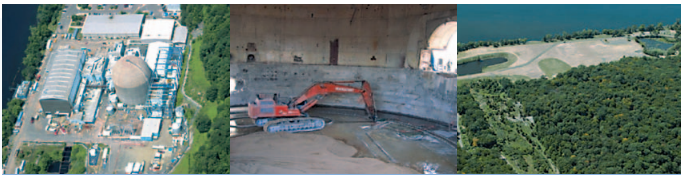
Anläggningen före avveckling.
